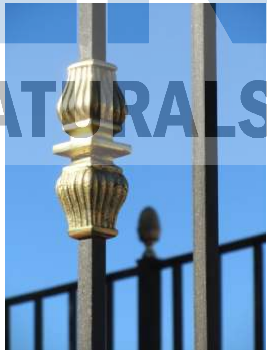
Detall de forja de ferro combinada amb llautó enmotllat.
