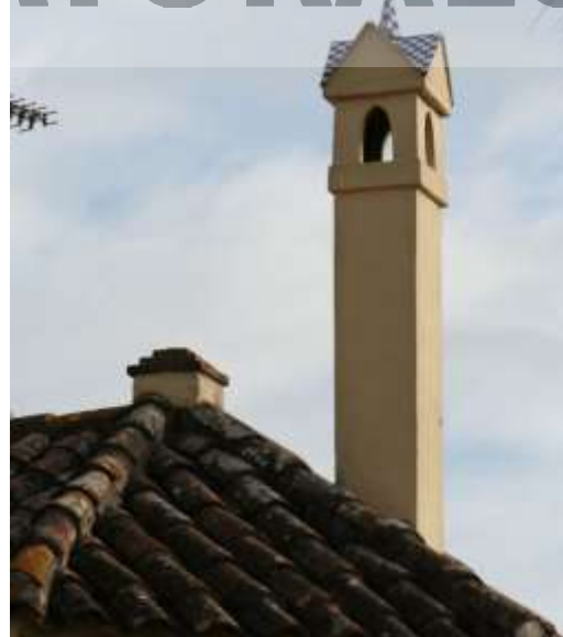
Xemeneia d'obra amb aplicació de rajoles per fer la seva teulada.
