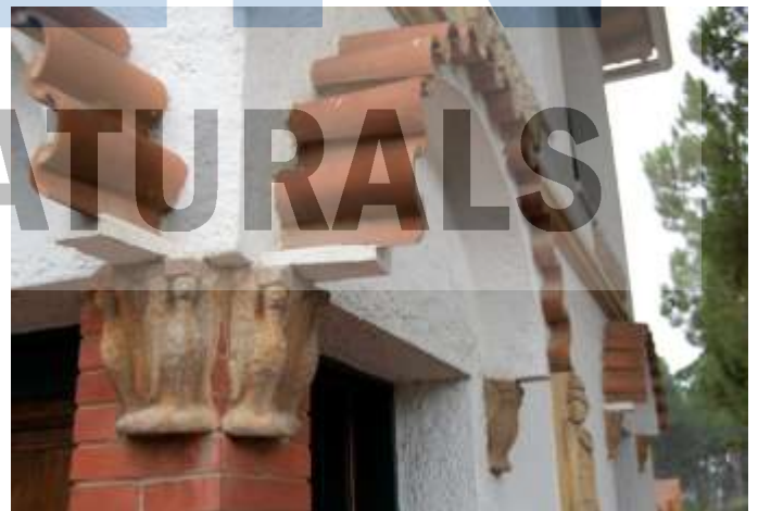
Teules àrabs disposades en forma d'arcs sobre les portes d'entrada d'una casa.
