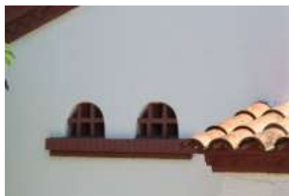
Espiralls funcionals fets amb corbes (curvetas) o maons.
