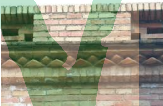
Sotabalcó solucionat a l'estil dels ràfecs de cairons en punta.
